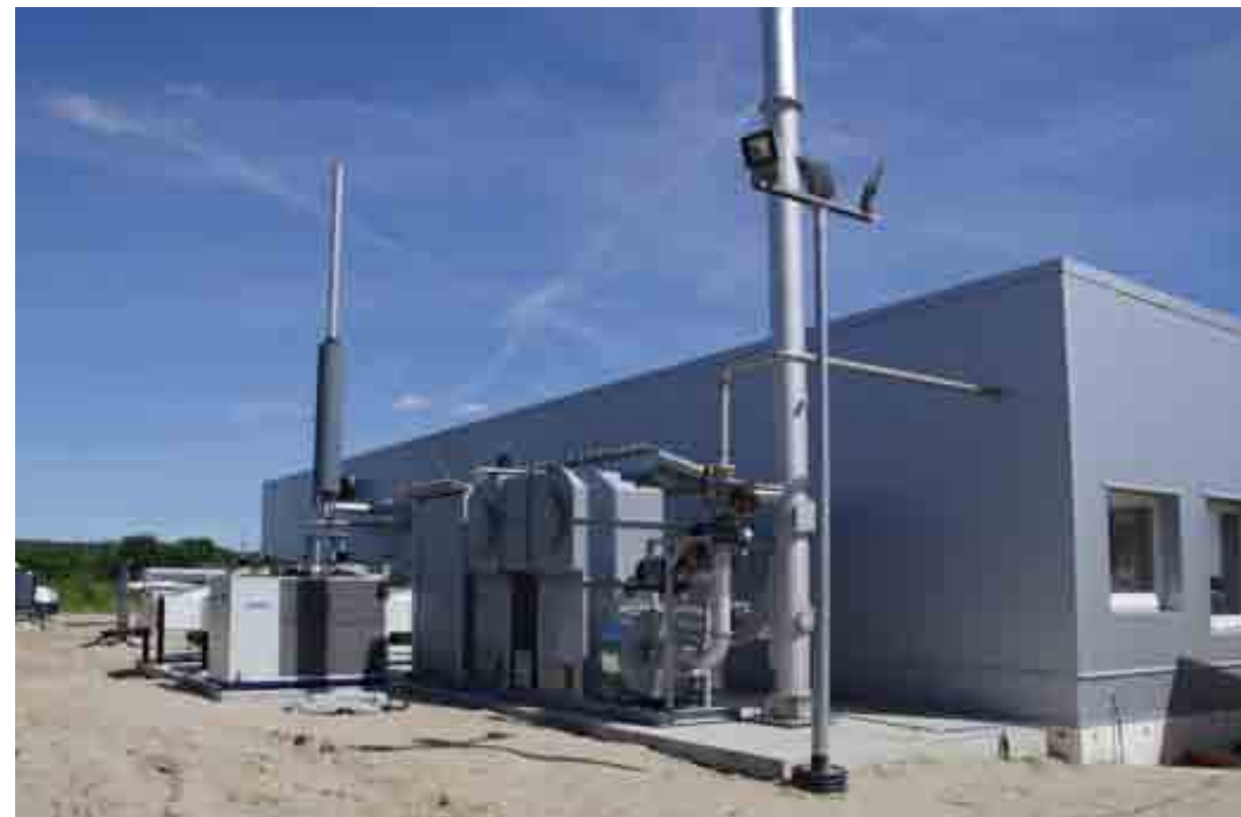
Außenansicht der ebenfalls 350 Nm³/h-leistungsstarken integrierten Gasaufbereitung in Köckte
