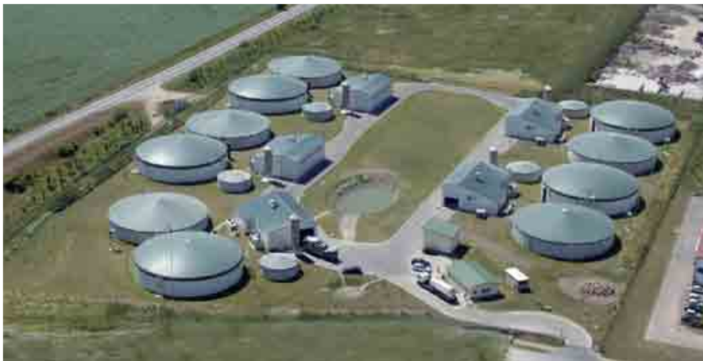
Anklam ist der erste von EnviTec erbaute Bioenergiepark. In fünf baugleichen Anlagen mit einer Kapazität von je 549 Kilowatt können hier bis zu 20.000 Megawatt Strom pro Jahr erzeugt werden.
