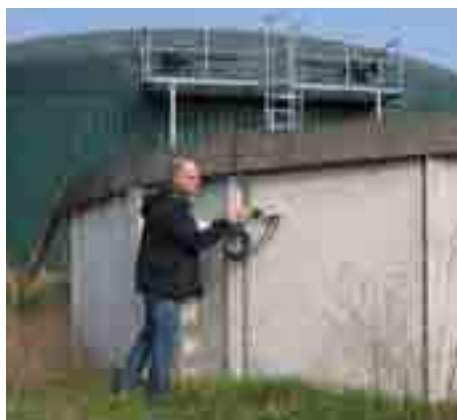
Sichtbare Mängel nimmt Dirk Terkowski bei einer Begehung auf und bespricht sie vor Ort mit dem Kunden.
