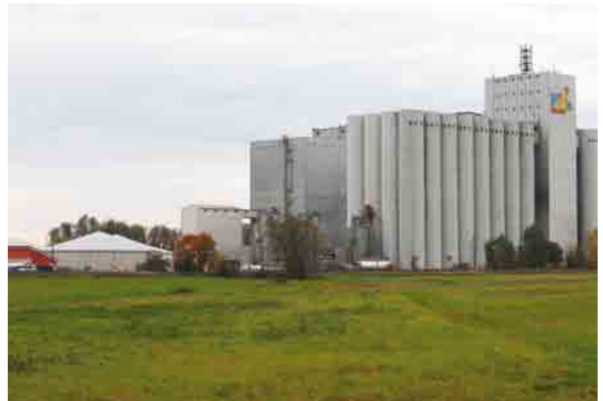
Die Biogasanlage der deuka-Tierfuttermittelfabrik in Herzberg/Brandenburg ist ein hervorragendes Beispiel für die intelligente und wirtschaftliche Nutzung ihrer Abfälle.
