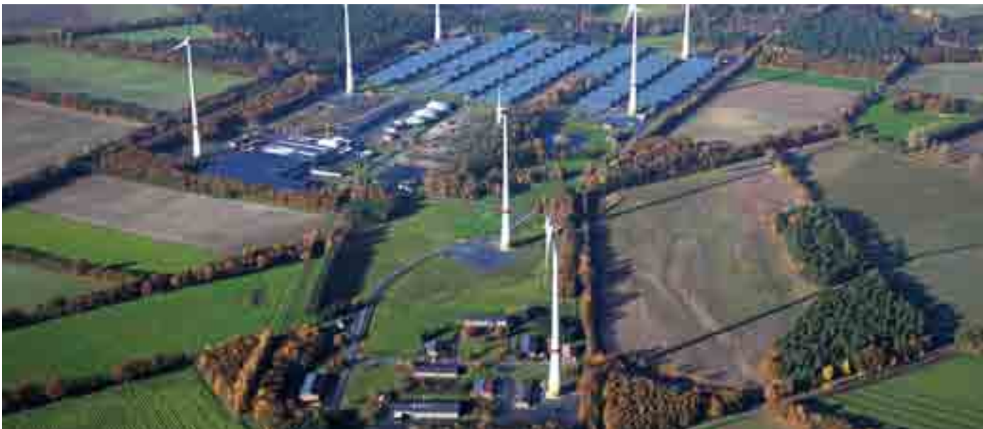
Sieben Windkraftanlagen, eine Biogasanlage auf Basis nachwachsender Rohstoffe, ein Biomassekraftwerk (der Bioabfallbehandlungsanlage des Kreises Steinfurt) und eine Photovoltaik-Anlage auf den Bunkerdächern erzeugen grüne Energie mit einer Gesamtleistung von 29 Megawatt.
