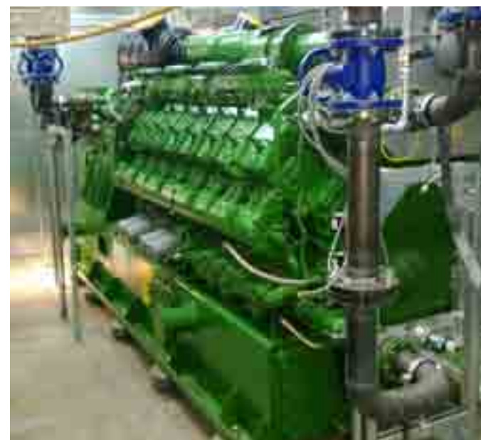
Das im September 2013 bei Leipzig in Betrieb genommene BHKW mit einer elektrischen Leistung von 1,5 MW liefert eine flexible Stromerzeugung bei gleichzeitig optimierter Wärmeauskopplung und stellt zusätzlich Regelenergie bereit.
